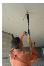
Vissage sur plafond en plaque de plâtre.
