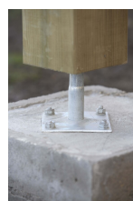
Fixation d'un pied de poteau
