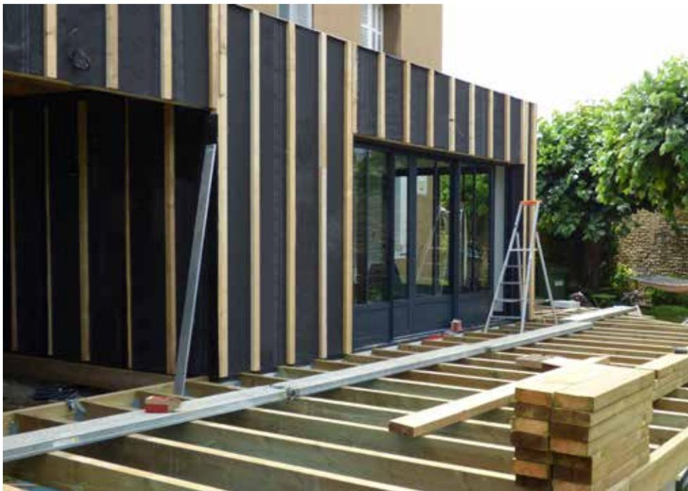
Il convient de vérifier les avis techniques des fabricants de bardage pour savoir si la pose d'une pare-pluie est nécessaire.
