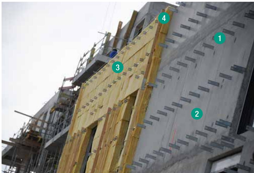
Le principe consiste en plusieurs étapes. Il s'agit d'abord de fixer les équerres **1** sur un support **2**. L'exemple ci-dessus présente le cas d'un support béton.
