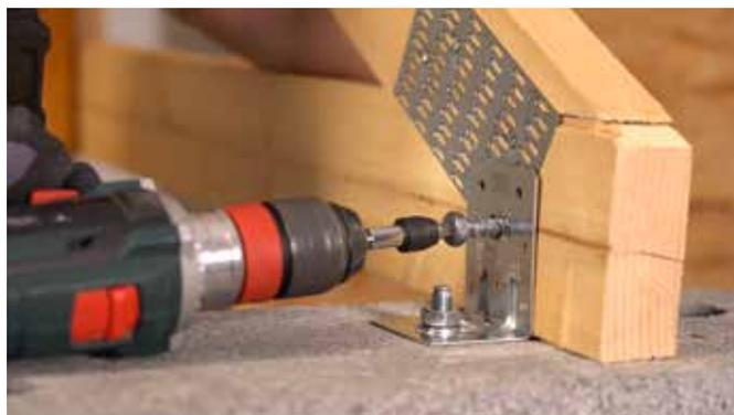
Autre exemple, la fixation de 25 fermettes s'effectue en 3 minutes avec la vis SSH contre 10 minutes avec un cloueur classique.
