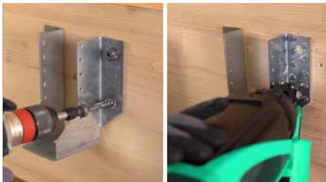
Une vis SSH remplace jusqu'à **7** pointes.
