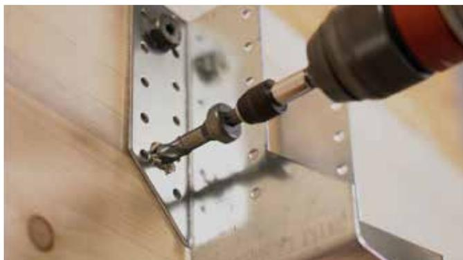
Par exemple, la pose de 20 sabots avec la vis SSH prend 13 minutes contre 20 minutes avec un cloueur en bande traditionnel.
