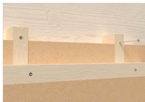
TTUFS utilisée dans les ossatures légères
