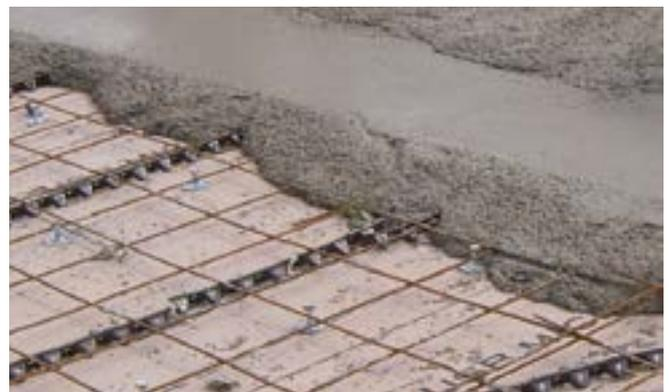
4. Coulage de la dalle béton sur l'ensemble du plancher. Une fois le béton durci, la dalle est structurellement ancrée aux murs latéraux et solidement connectée au plancher bois.
