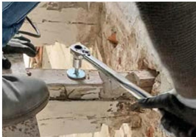
Contrôle du couple de serrage avec une clé dynamométrique
