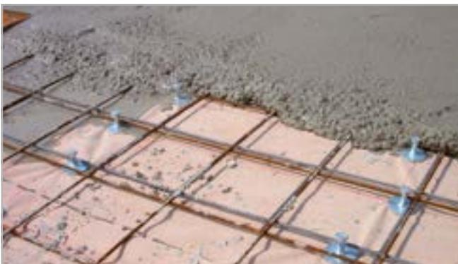
Les vis FM-CT sont posées avant le coulage du béton sur la surface en bois.
