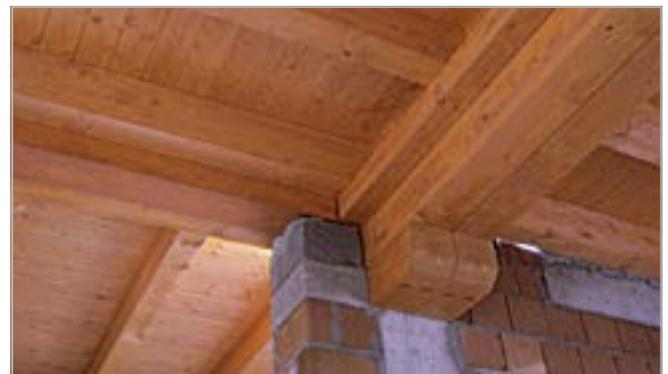
Ce type de construction bois permet de tirer pleinement parti des avantages offerts par une dalle composite bois-béton.
