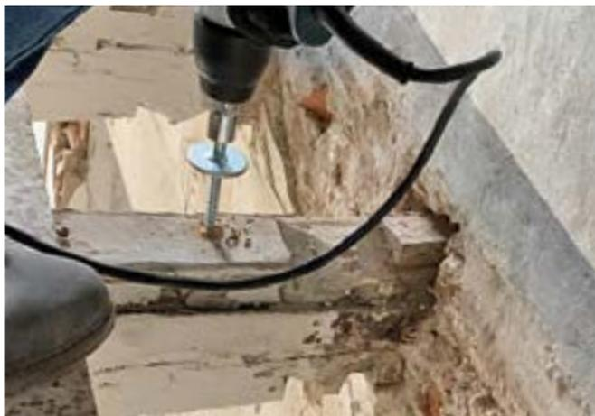
Installation des connecteurs à l'aide d'une visseuse
